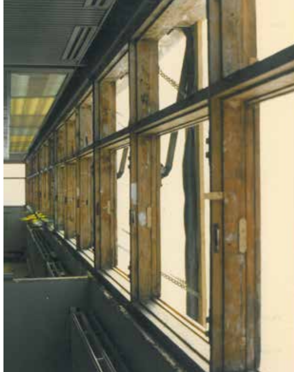
Aukion puoleiset toisen kerroksen puuikkunat ja kammit on kunnostettu restauroinnin ensimmäisessä urakassa. Oikeanpuoleisessa kuvassa kunnostetut ikkunat asennettuina. (Kuvat 1998)
