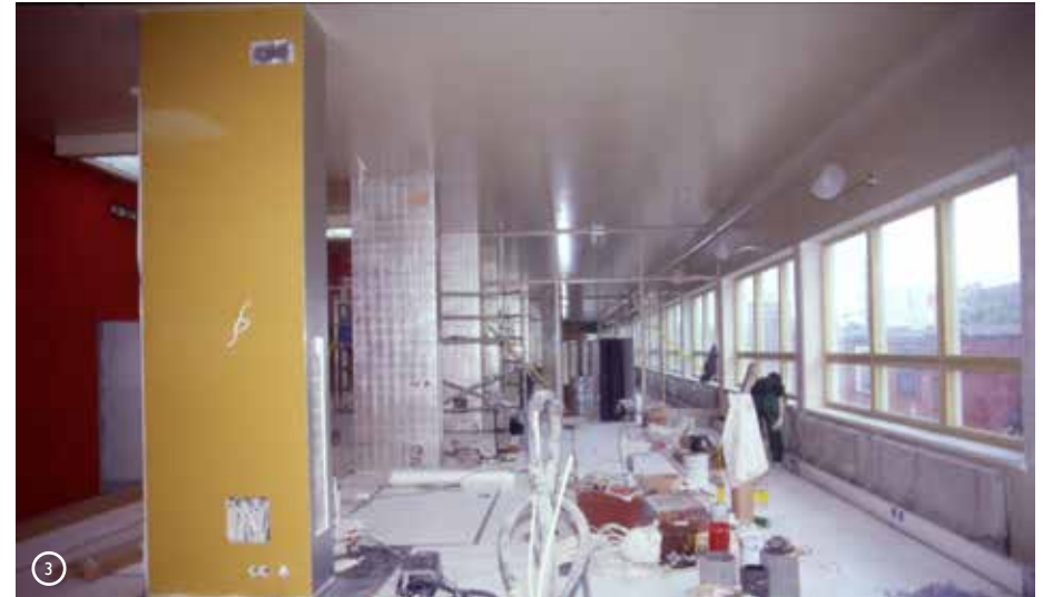
Restauroinnissa IV-hormit toteutettiin osaksi pilareita. Kuvat yllä restauroinnin aikaisia.
