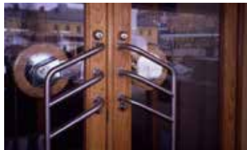
Restauroinnissa valmistettiin uusia ovia alkuperäisen kaltaisin detaljein. (Kuvat: Alli Oy, v.1998)
