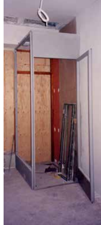
Osa tuulikaapeista on rakennettu huonekorkeutta matalammiksi, jotta valaisinsyvennykset on voitu säilyttää katkeamattomina. Yllä rakennusaikainen kuva, muut kuvat v.2015.
