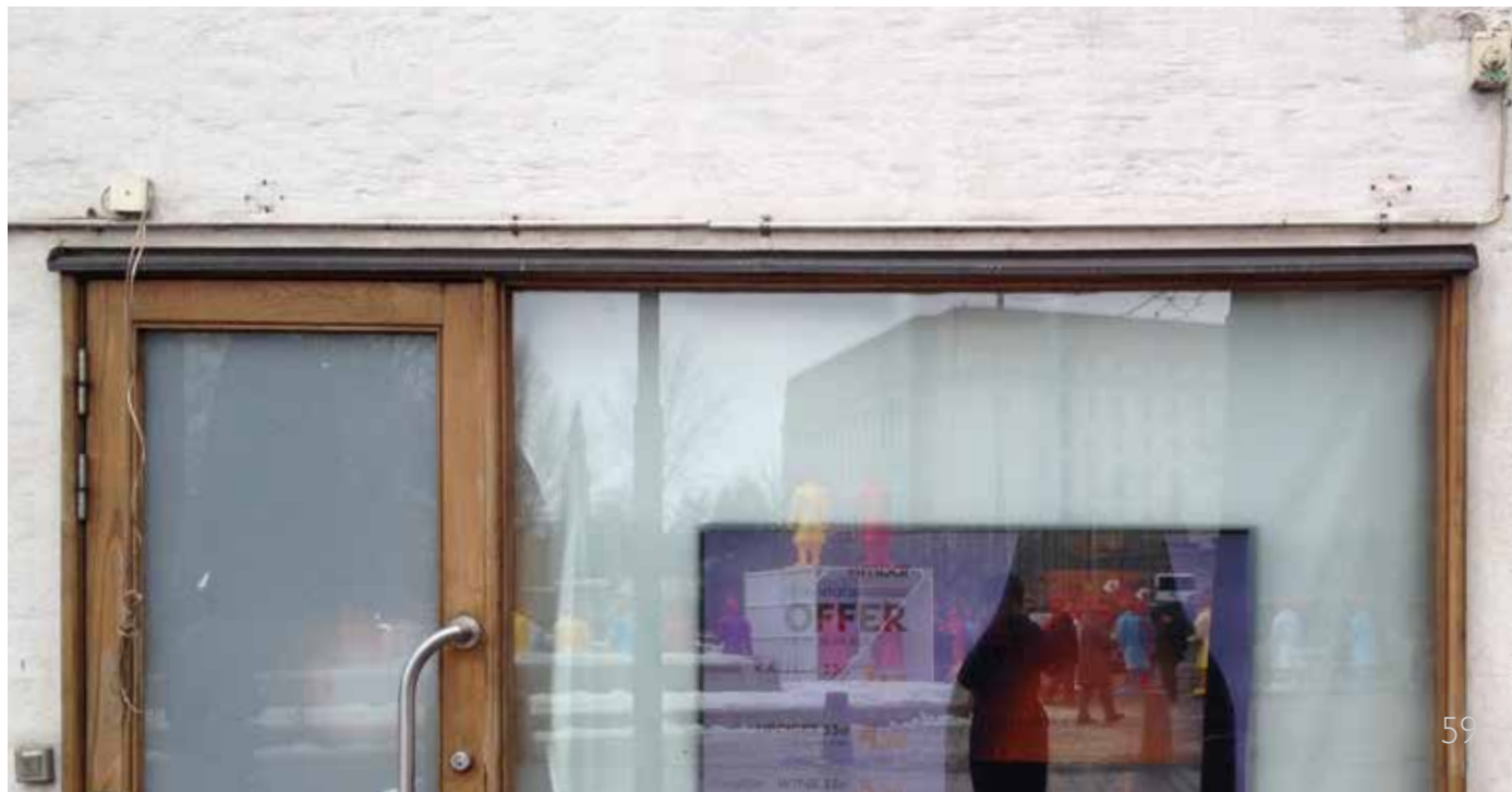
Näyteikkunoiden kammit tulevat ulos julkisivupinnasta. Markisiiton näyteikkuna on suojattu peltiilipalla. (Kuva 2015)
