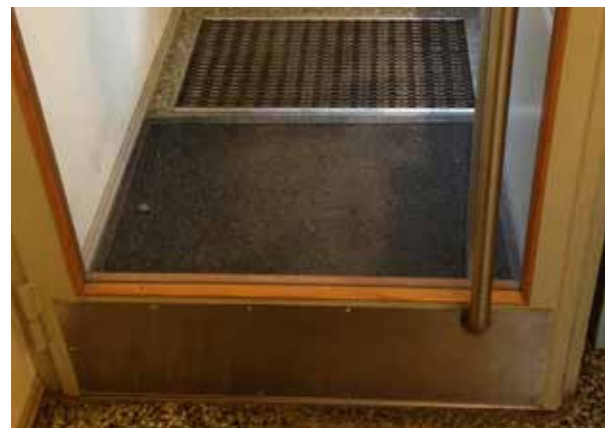
Restauroinnissa tuulikaappien lattioihin toteutetut kuramattosyvennykset ovat säilyneet muutamia poikkeuksia lukuun ottamatta.
