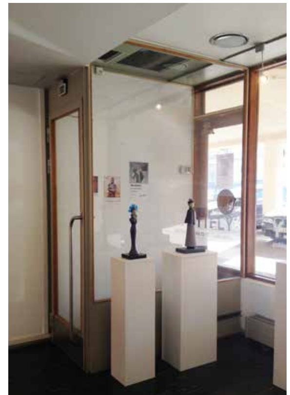
Osa tuulikaapeista on rakennettu huonekorkeutta matalammiksi, jotta valaisinsyvennykset on voitu säilyttää katkeamattomina. Yllä rakennusaikainen kuva, muut kuvat v.2015.
