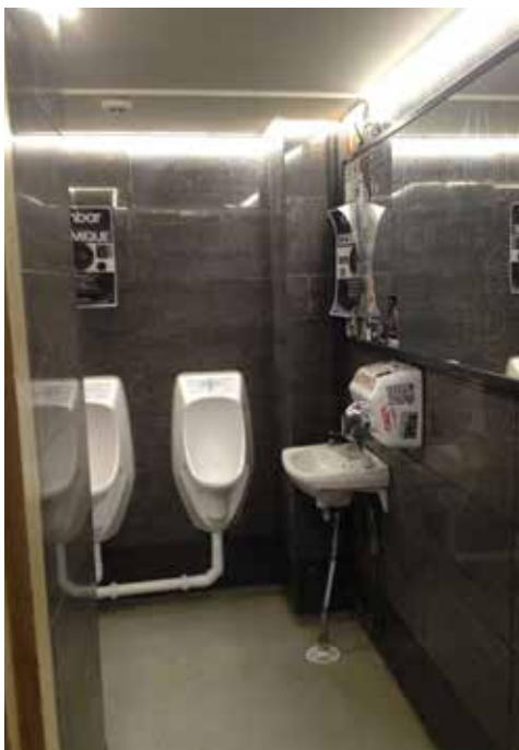
Vasen kuva : osa rakennuksen wc-tiloista on laatoitettu uudestaan restauroinnin jälkeen. Myös wc-kalusteita on vaihdettu. Kuvassa Mbarin wc.
