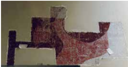
Restauroinnissa portaan alkuperäinen seinämaalaus löytyi maalikerrosten alta. Kuva vuodelta 1997.
