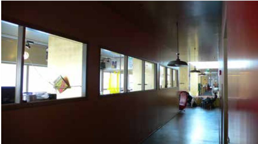
Restauroinnissa toteutettiin uutena lisäyksenä toisen kerroksen tiloihin sisäikkunoita, alkuperäisiä väliovia kunnostettiin sekä uusia valmistettiin alkuperäisovien mallien mukaan. Restauroinnin jälkeen on erityisesti liiketiloihin lisätty uusia väliovia, jotka ovat yleensä perusmallisia laakaovia. Sivun kuvat v.2015.
