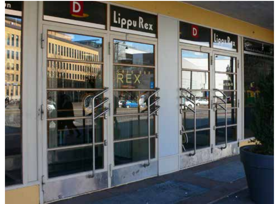
Elokuvateatterin sisäänkäynnin teräslasiovet ja puiset lasituslistat v.2015.
