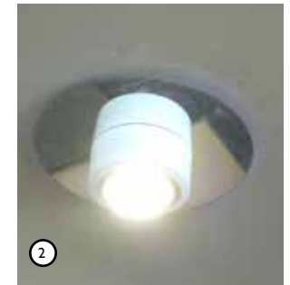
Restauroinnissa rekonstruoitujen valaisimien rikkoutuneet lasikuvut on korvattu poikkeavilla valaisimilla.
