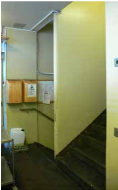
Restauroinnissa rakennettu uusi ravintolan ja kellarin välinen huoltoporras ja tavarahissi; porras on mustaa mosaiikkibetonia ja kaiteet maalattua terästä.
