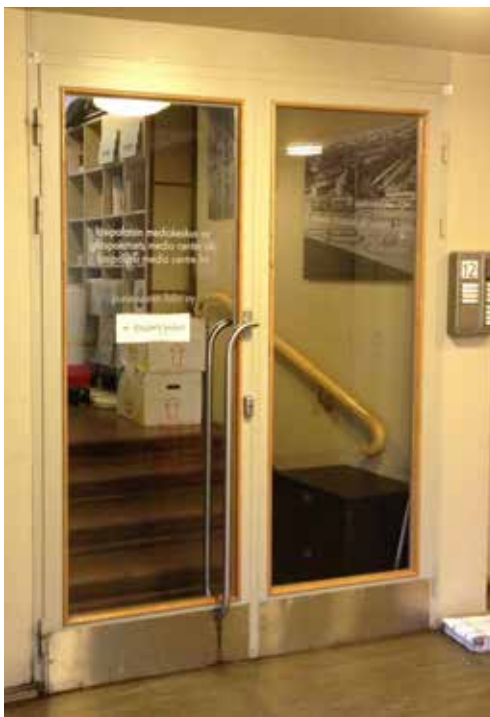
Oikealla Restau- roinnissa kunnos- tettu puuovi ja uutena valmis- tettu teräslasiovi nykyasuissa.
