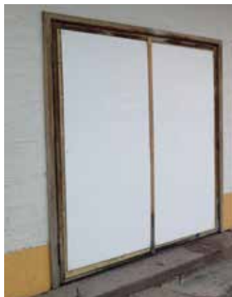
Bio Rexin uloskäynnin vaneripintaisiin oviin on restauroinnin jälkeen kiinnitetty mainosten kiinnittämiseen soveltuvat levyt.
