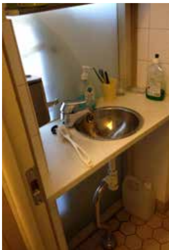
Alkuperäisiin oviaukkoihin restauroinnissa upotetut allastasot ovat säilyneet restauroinnin jälkeen inventointihetken saakka.
