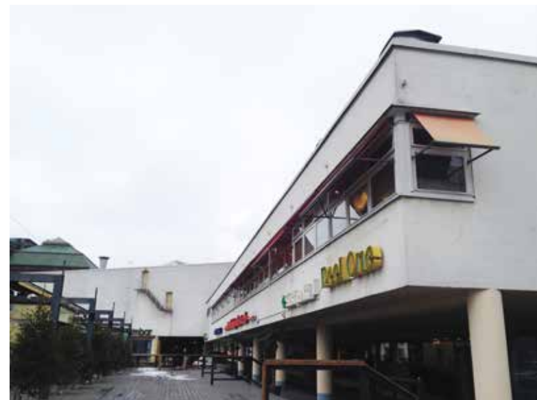
Keväällä 2015 julkisivujen rappauspinta kaipaa kunnostusta, portaan punainen pinnoite on kulunut ja markiisien värit ovat paikoitellen haalistuneet.
