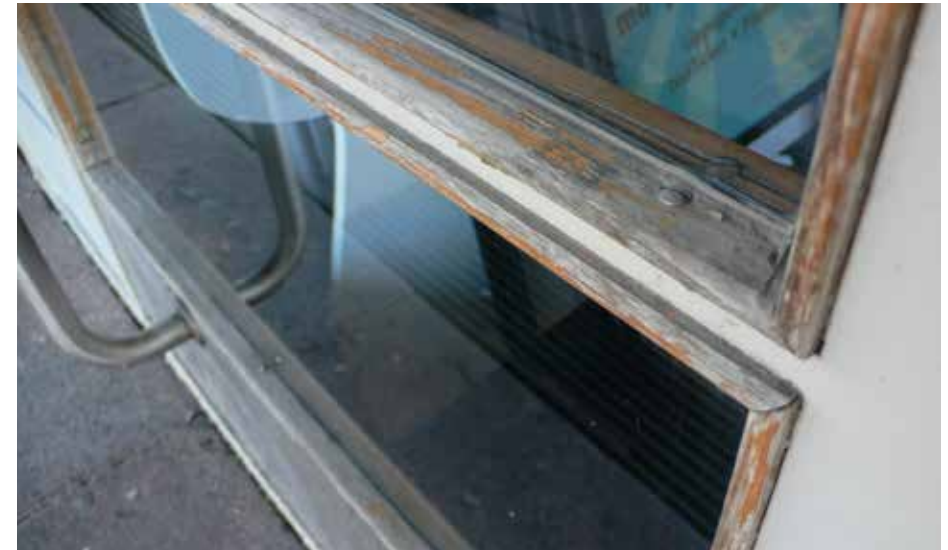
Elokuvateatterin sisäänkäynnin teräslasiovet ja puiset lasituslistat v.2015.
