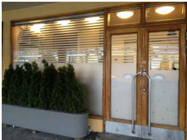
Restauroinnin merkittävimpiä lisäyksiä on ollut uuden huoltoportaan rakentaminen. Aukion puolelle on tuolloin puhkaistu porrashuoneeseen johtava pariovellinen sisäänkäynti.
