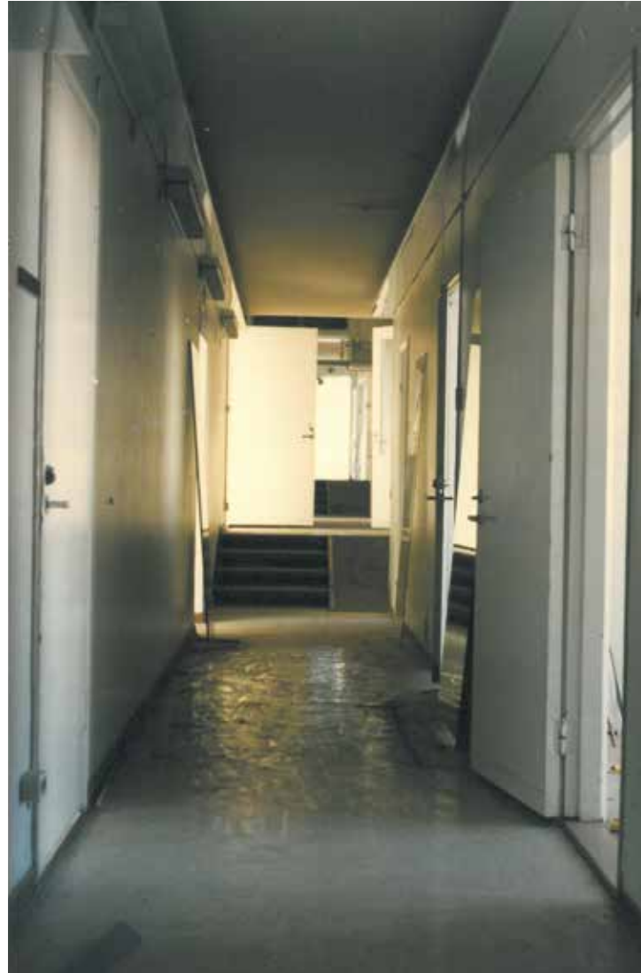
Toimistokäytävä ennen restaurointia.
